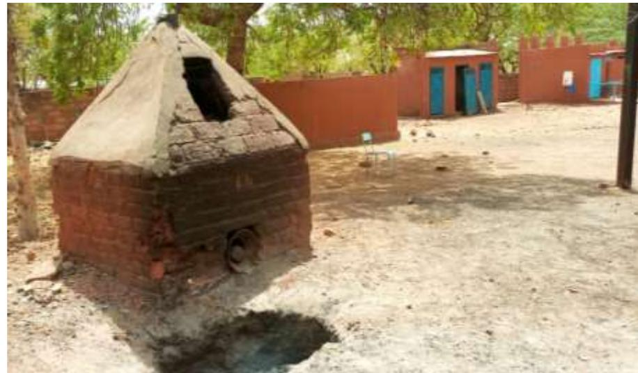
**Un incinérateur en mauvaise posture et un bloc latrine en arrière avec une porte en mauvais état, centre de santé**
