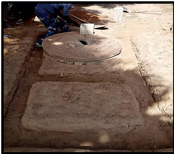
Aperçu du soubassement de la superstructure de la latrine
