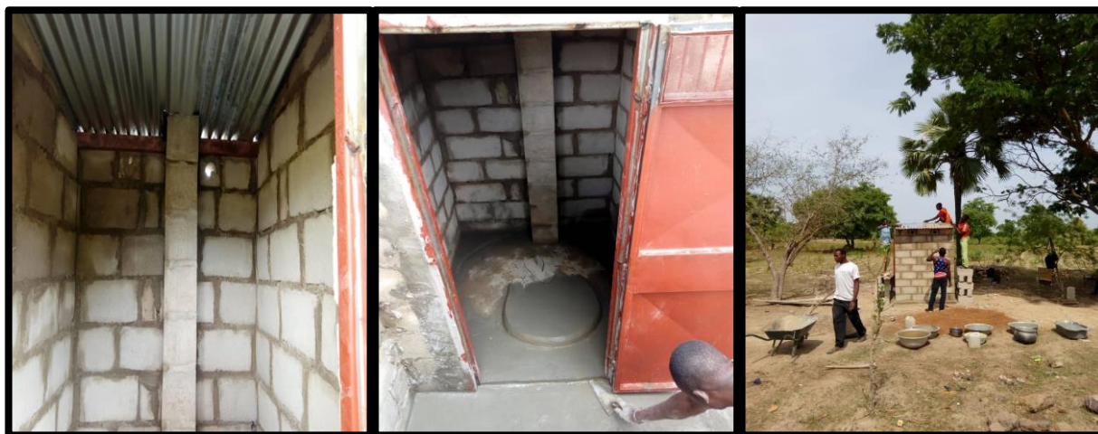
Un aperçu de la latrine prototype achevée
