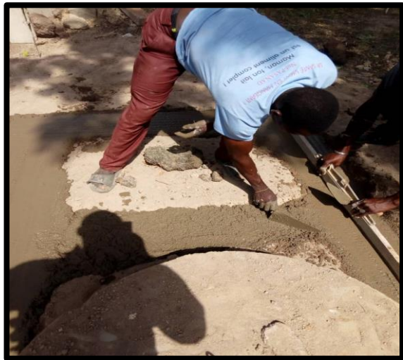
Aperçu du soubassement de la superstructure de la latrine
